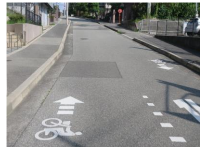
非幹線道路の整備例(吹田市内)
