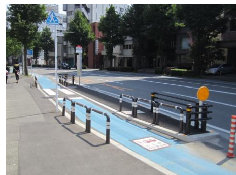
交通島を設置している例(福岡市)
