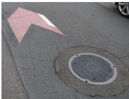
マンホールの蓋に滑り止め加工をしている例(京都市)
