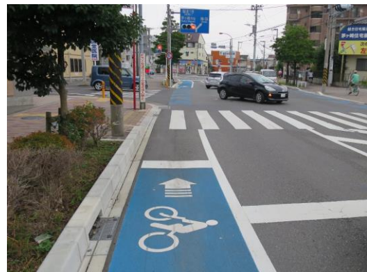
停止線前出しの例(茅ヶ崎市)
