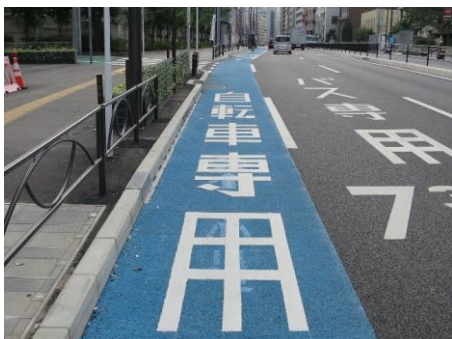
街渠をエプロン幅の狭い平坦性の高いものに置き換えた例(東京都文京区)
