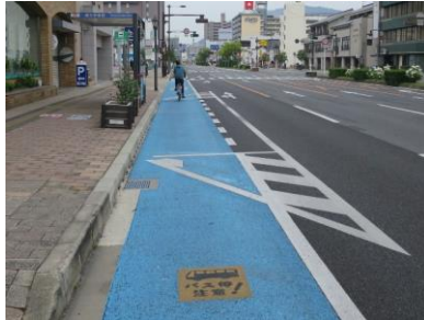
カラー舗装区間の例(福山市)
