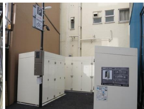
高級スポーツ車専用ロッカーの設置例 (東京都中央区)
