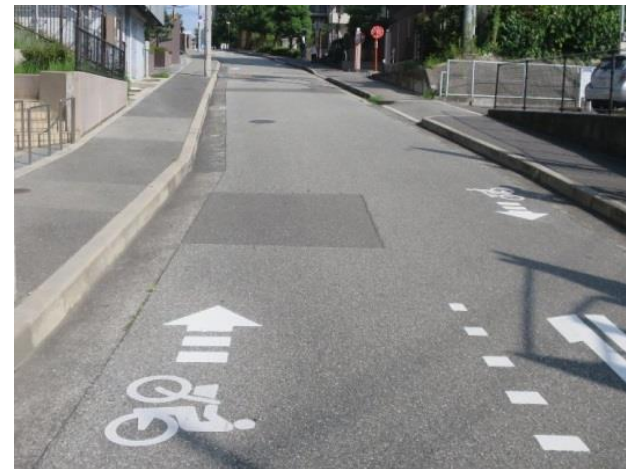
非幹線道路の整備例(吹田市)
