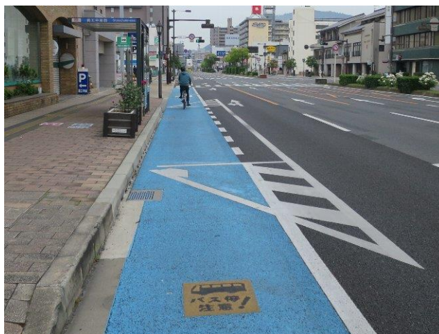
カラー舗装区間の例（福山市）
