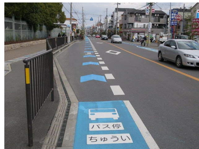
バスベイ型バス停において矢羽根を直線的に設置している例（枚方市）
