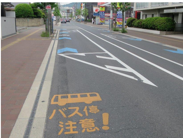
矢羽根整備区間の例（福山市）
