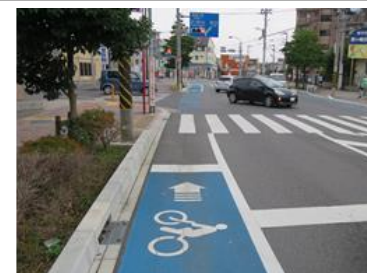
停止線前出しの例（茅ヶ崎市）
