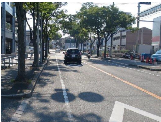
車道左側に余裕がある道路の例
