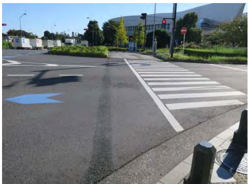
写真 5-10 自転車横断帯撤去の例 (横浜市)
