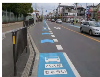
写真 5-17 バスベイ型バス停において矢羽根を直線的に設置している例（枚方市）
