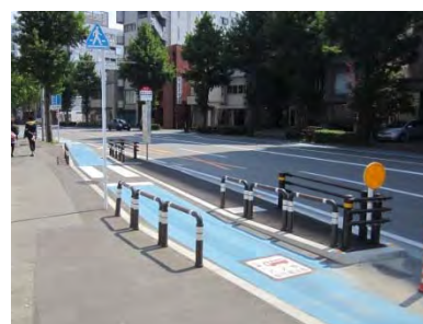
写真 5-18 交通島を設置している例（福岡市）
