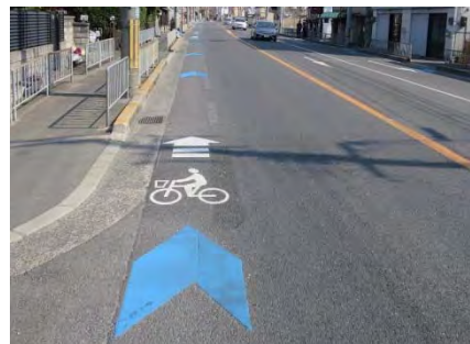
写真 5-19 路面表示設置例（吹田市）
