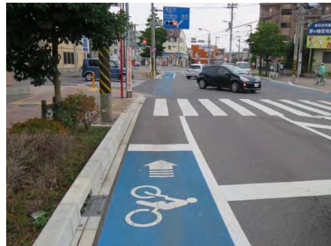
写真 5-9 停止線前出しの例(茅ヶ崎市)
