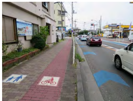
写真 5-4 車道上の自転車通行空間整備と通行位置を明示した自転車歩行者道の併用の例（茅ヶ崎市）
