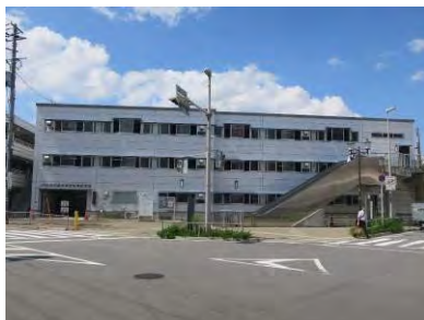
写真 3-8 階層式自転車駐車場 (JR吹田駅)
