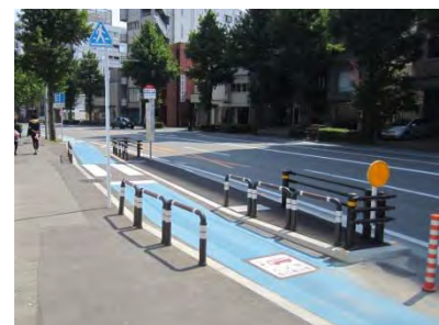
写真 5-18 交通島を設置している例（福岡市）
