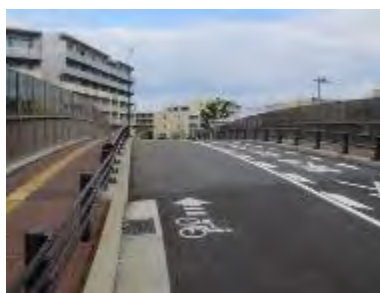
⑤ 車道混在（阪急千里山駅）
