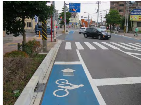
写真 5-9 停止線前出しの例(茅ヶ崎市)
