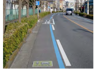
写真 5-16 カラーライン区間の例（川口市）
