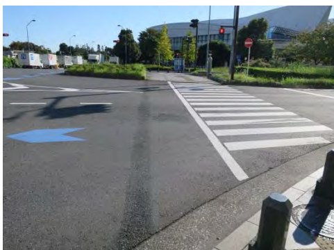
写真 5-10 自転車横断帯撤去の例 (横浜市)
