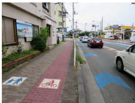
写真 5-4 車道上の自転車通行空間整備と通行位置を明示した自転車歩行者道の併用の例（茅ヶ崎市）
