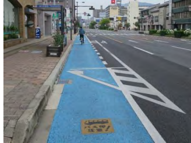
写真 5-15 カラー舗装区間の例（福山市）
