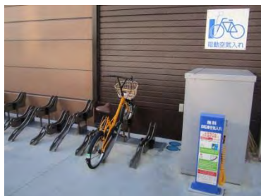
写真 5-33 電動空気入れを設置した自転車駐車場(所沢市)
