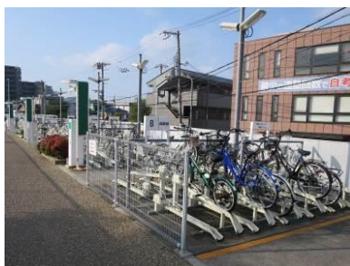
写真 3-11 電磁ラック式自転車駐車場 (阪急豊津駅)
