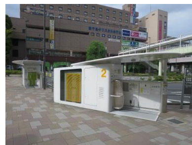
写真 3-12 機械式地下自転車駐車場 (阪急南千里駅)
