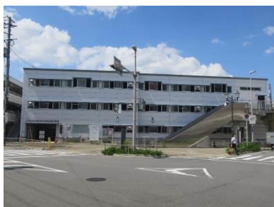
写真 3-10 階層式自転車駐車場 (JR吹田駅)
