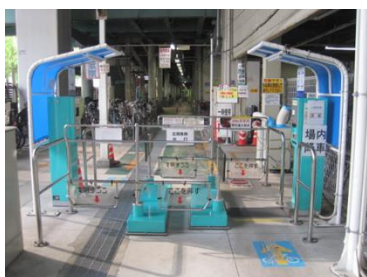
写真 5-40 機械式出入口ゲート(吹田市)
