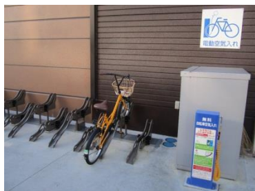
写真 5-36 電動空気入れを設置した自転車駐車場(所沢市)
