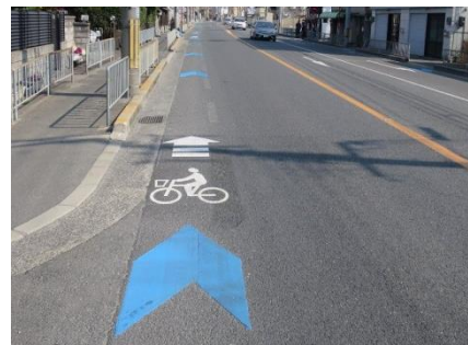
写真 5-19 路面表示設置例（吹田市）
