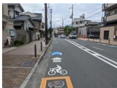
⑦ 車道混在（市道）片山高浜線
