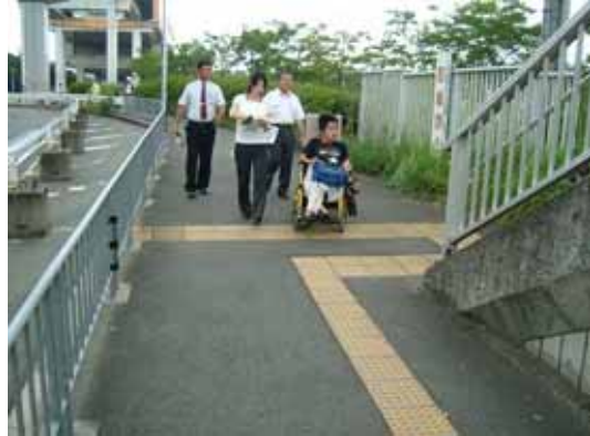
しかくしょうがいしゅうどうよう 視覚障害者誘導用ブロックの不適切な設置
