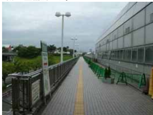
図 -10 連絡デッキの現況
