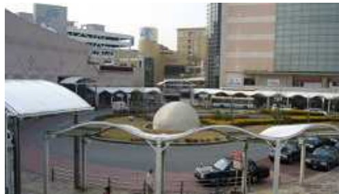
図 -12 千里北公園古江線 (駅前広場) の現況
