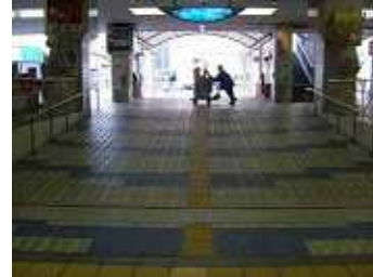
スロープの勾配が急
