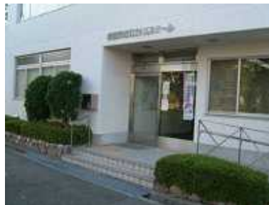
図 -22 古江台市民ホールの現況
