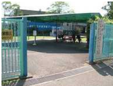
図 -26 北千里市民プールの現況
