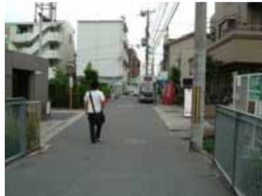
図 -19 岸部南5号線の現況
