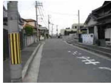
ふくいん ふそく 幅員の不足
