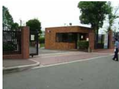
出入口部の現況
