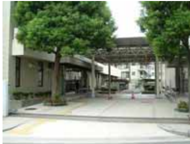
図 -24 吹田市立青少年クリエイティブセンターの現況
