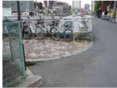
すりつけ部の勾配が大きい
