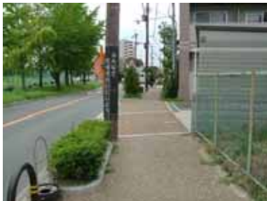
北側歩道の現況
