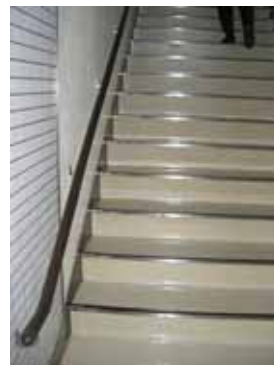
階段手すりの状況
