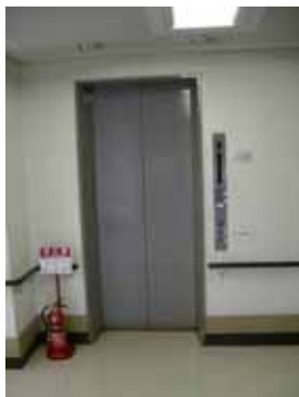
エレベーター前の状況
