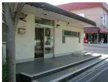
図 -23 青山台市民ホールの現況
