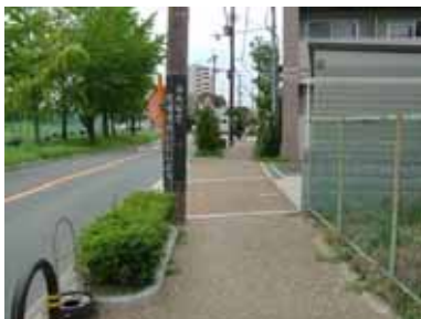
北側歩道の現況
