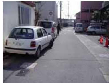
歩道の未設置
