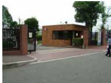
出入口部の現況
