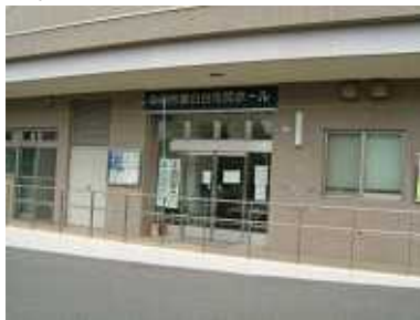
図 -24 藤白台市民ホールの現況
