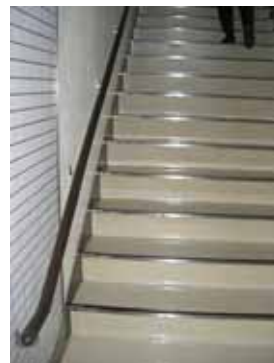
階段手すりの状況
