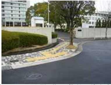
図 -15 藤白台2号線の現況
