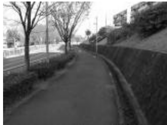
東側の歩道の現況
