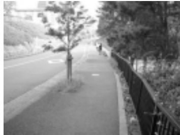
西側の歩道の現況
