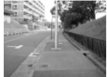
歩道の真ん中にある照明柱
