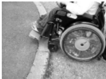
歩道と車道の段差が大きい
