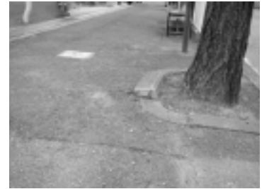
路面舗装の老朽化
