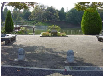
メインエントランス（改修）
