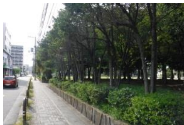
樹間の狭小化による 見通しの障害
