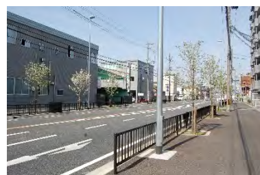
都市計画道路「十三高槻線」の整備完了区間
