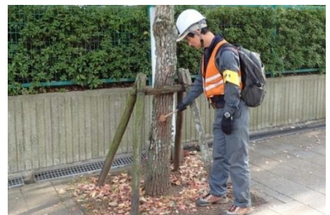
樹木健全度調査
