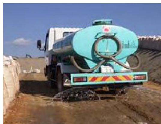
【工事関連車両の走行路への散水】
