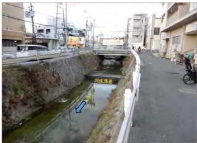
①上ノ川橋下流（工事起点）
