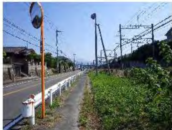
施工前状況：発進側から到達側を見る
