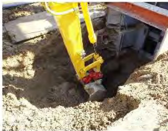
施工状況：切羽掘削状況
