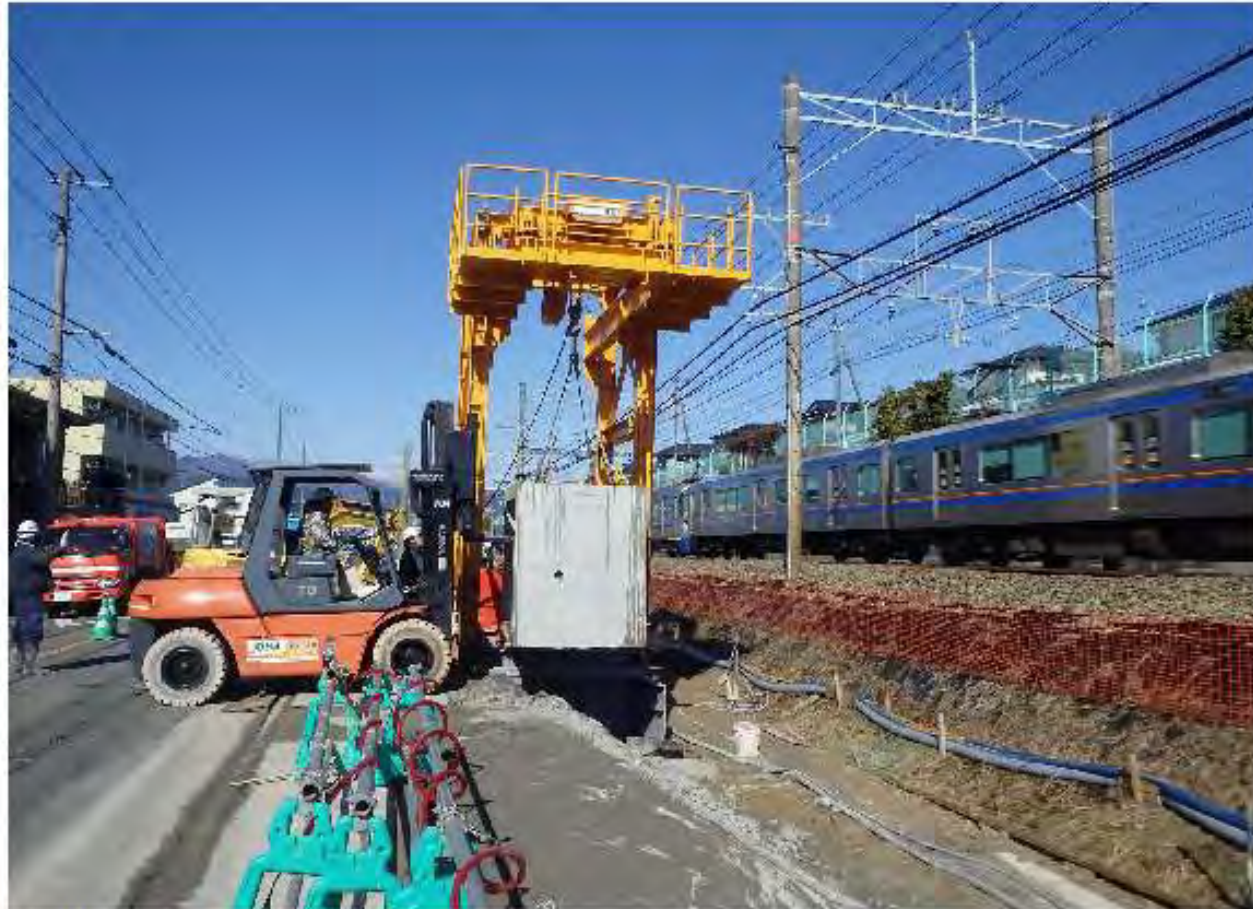
施工状況：ボックスカルバート吊り下ろし状況
