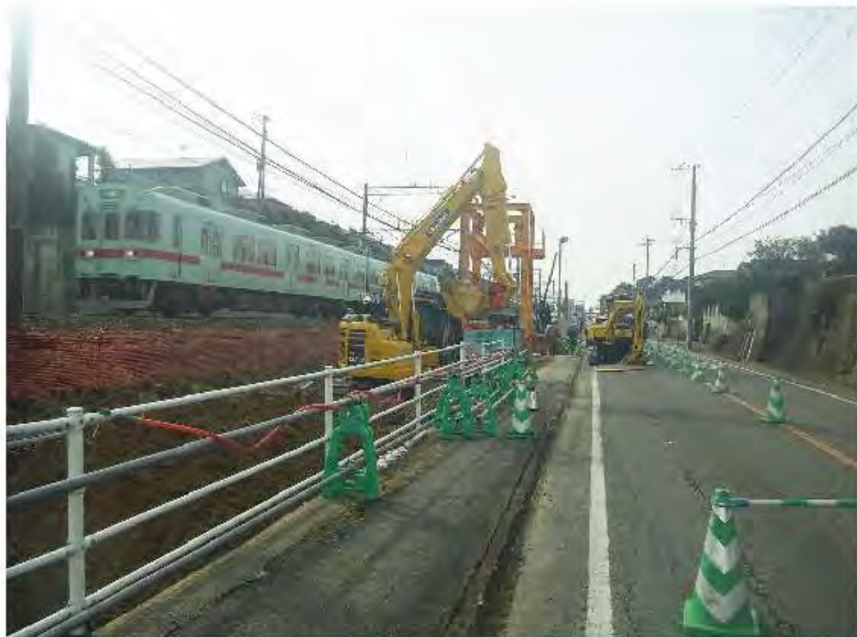
施工状況：掘進状況
