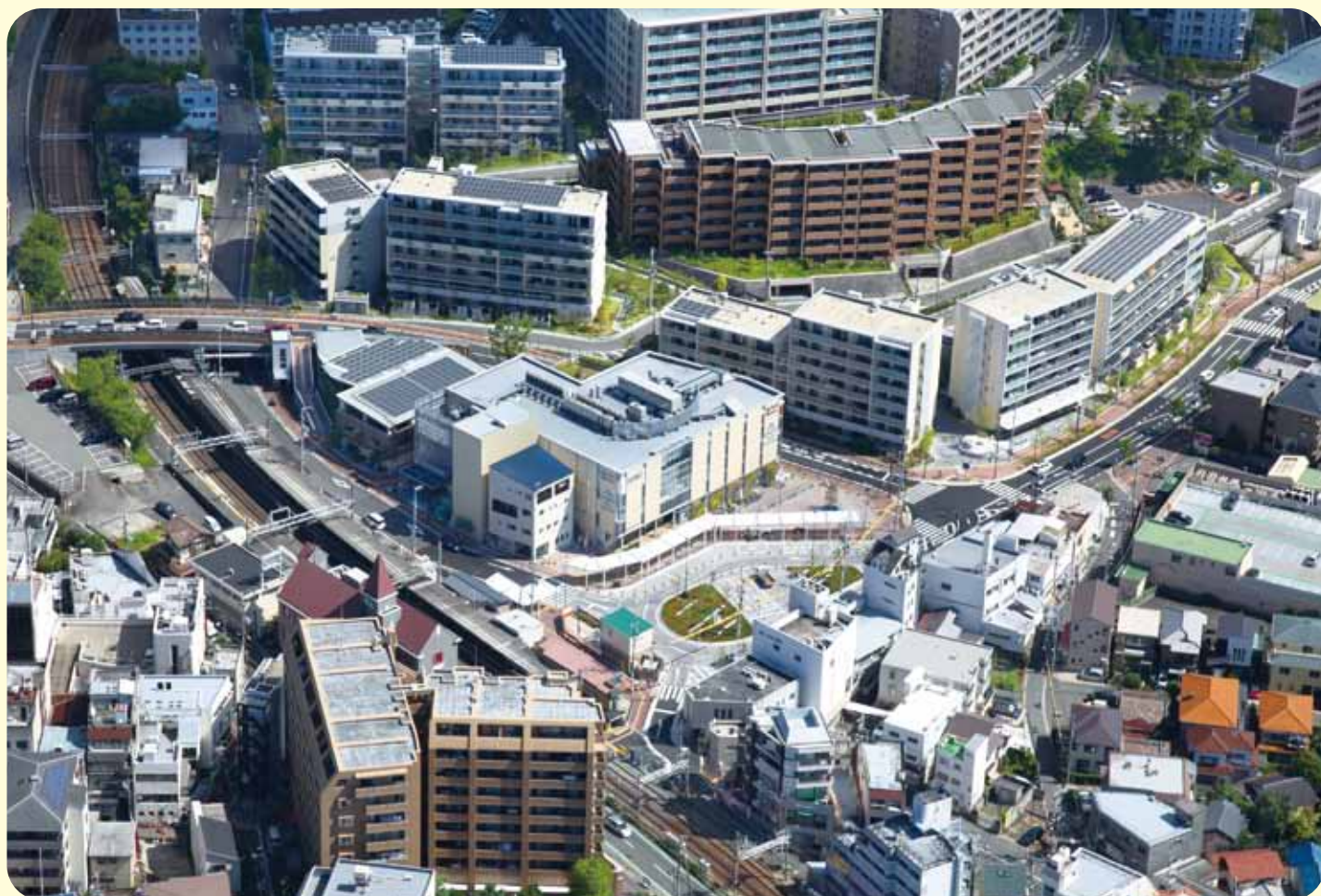
現地撮影(平成28年8月21日)
