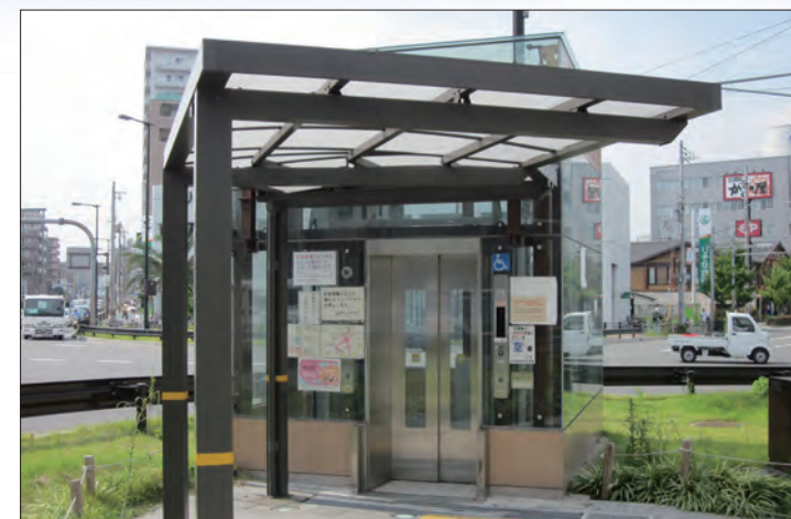
エレベーター施工例
