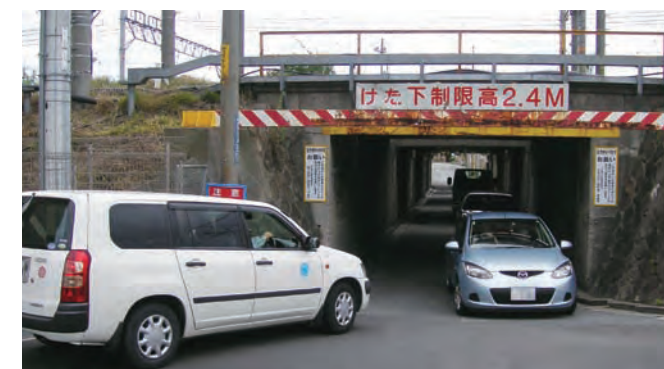
現在の東西道路(市道南吹田57号線、上新田架道橋)
