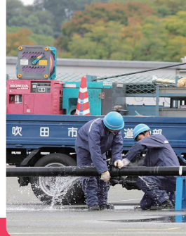
漏水の復旧訓練の様子
