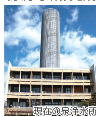
現在の泉浄水所
