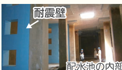
配水池の内部
