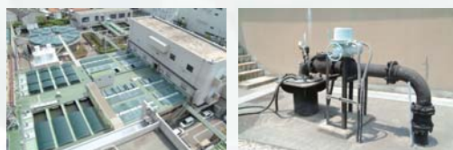
地下水をくみ上げる井戸
