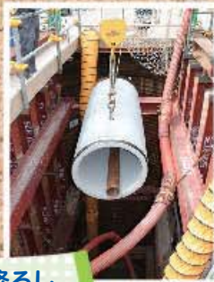
推進管吊降ろし
