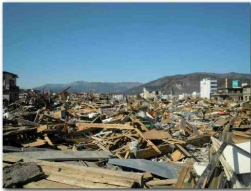
東日本大震災による被害
