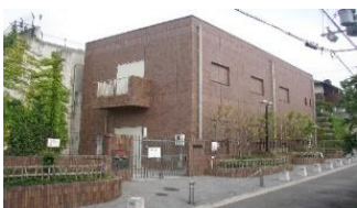
千里山配水場
