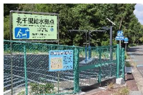
北千里給水拠点
