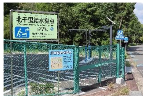
北千里給水拠点
