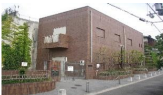
千里山配水場
