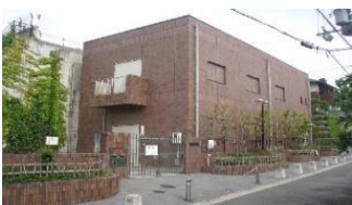
千里山配水場
