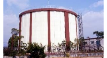
佐井寺配水場
