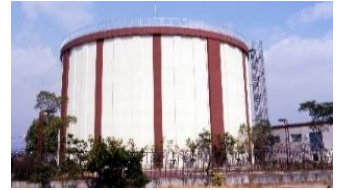
佐井寺配水場
