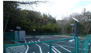
北千里給水拠点
