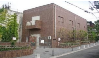
千里山配水場
