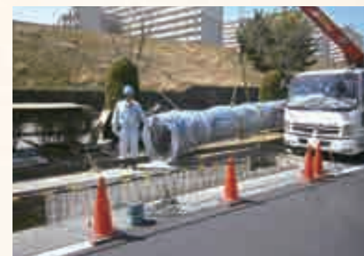
水道管の布設工事
