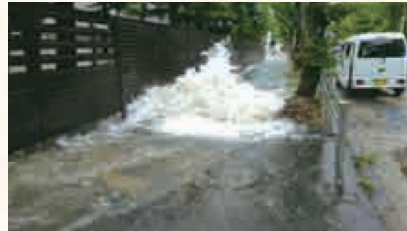
写真4-1 大阪府北部地震での管路の被害状況 (平成30年度(2018年度) 水道技術管理者研修資料より)
