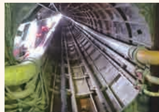
片山浄水所・泉浄水所 連絡管布設工事シールド内
