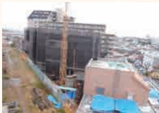
片山浄水所水処理施設更新工事
