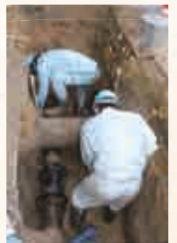
水道管の維持管理（漏水修繕）
