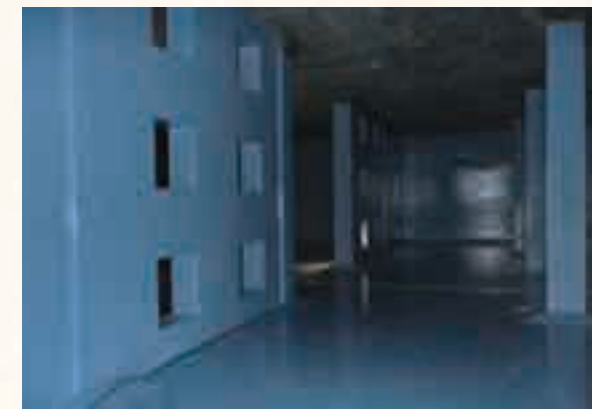
写真 配水池の耐震化(耐震壁) (片山浄水所 第4配水池)
