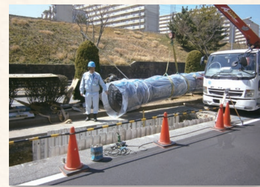
水道管の布設工事
