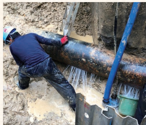
写真7-2 漏水状況
