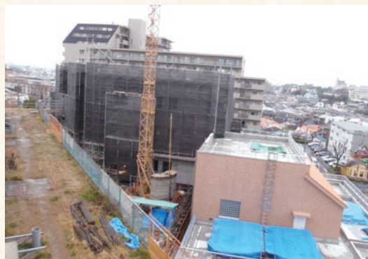
片山浄水所水処理施設更新工事
