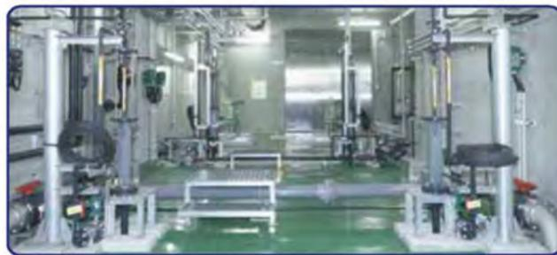
薬品室では、3種類の薬品を定めた量で各槽へ注入しています。
