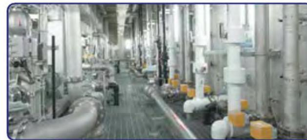
自動で膜ろ過したり、空気を送ったり、洗浄したりするための配管が並んでいます。
