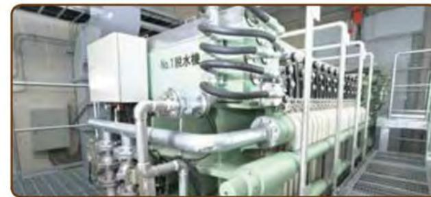
脱水機により1日最大1.3tの脱水ケーキを作ることができます。
