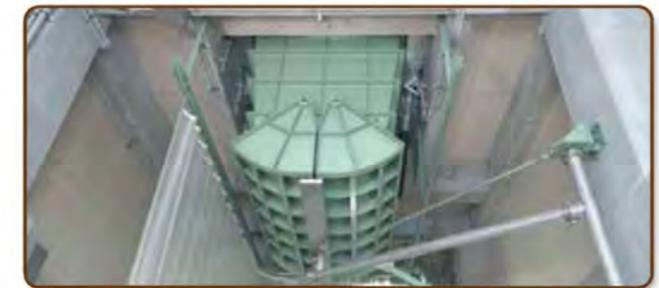
ケーキホップで脱水ケーキを貯留します。搬出時はホップが開き、トラックに脱水ケーキが積み込まれます。
