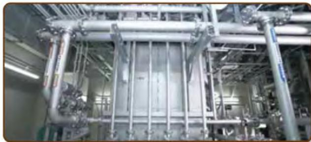
膜濃縮装置は、鋼製のタンクの中に膜モジュールを収納しています。
