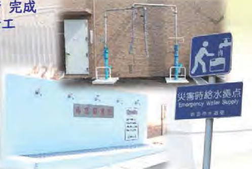
新しく設置した応急給水栓
