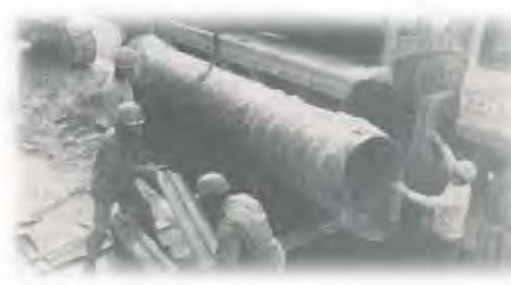
府営水道受水管工事の様子
