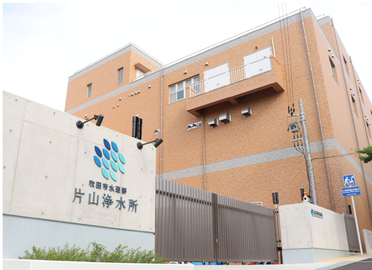
片山浄水所新施設
