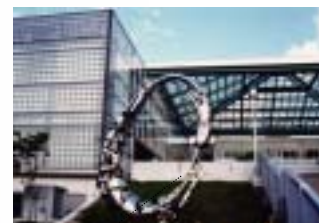
資源リサイクルセンター (くるくるプラザ)
