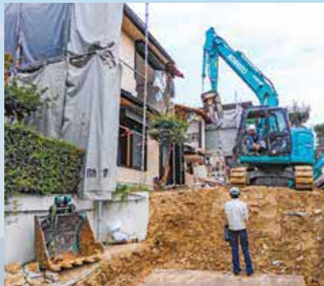
市職員による解体現場への立ち入り検査
