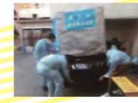
▲給水タンクを 組み立て設置する
