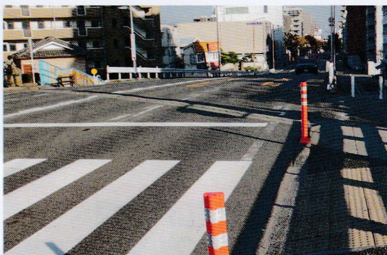
新糸田川橋の横断歩道につけられたポール
