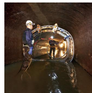
管更生工事の施工中・施工後の状況写真 （製管工法の例）
