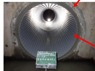
管更生工事の施工中・施工後の状況写真 （製管工法の例）
