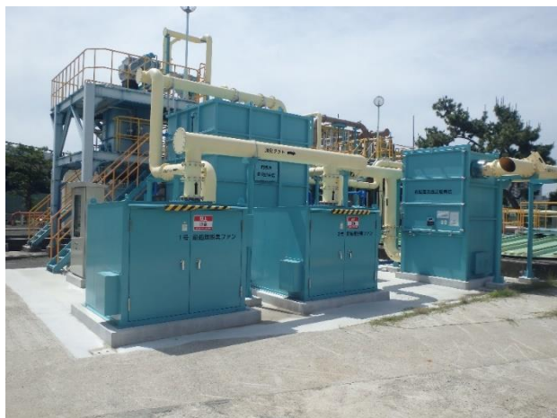
機械設備工事
