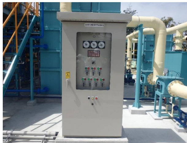
電気設備工事
