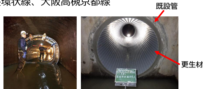
管更生工事の施工中・施工後の状況写真 （製管工法の例）
