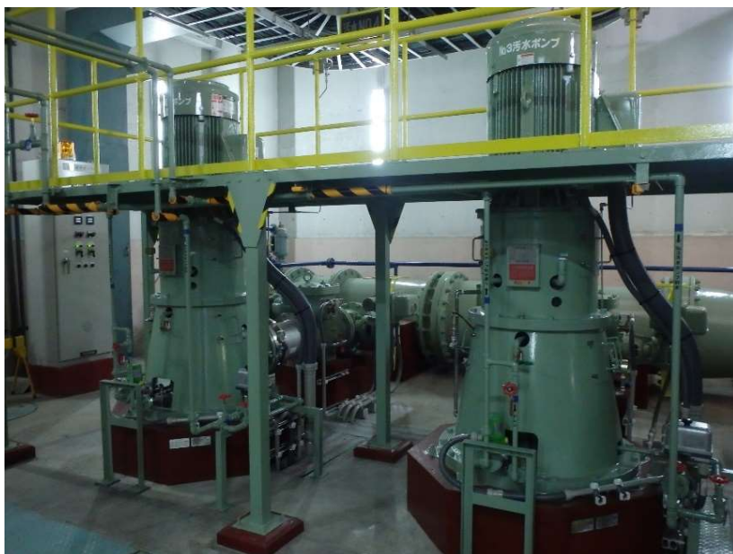
機械設備工事（汚水ポンプ3・4号）
