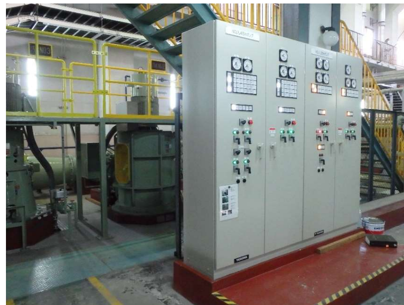
電気設備工事（汚水ポンプ3・4号現場操作盤）
