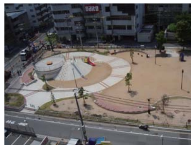
排水ポンプが設置された江の木公園
