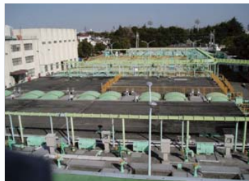
川面下水処理場
