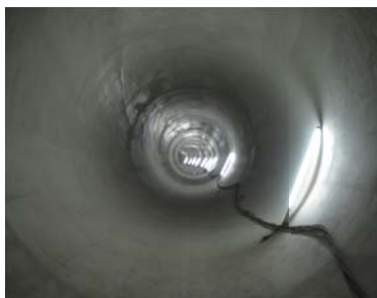
完成した豊津工区増強管
