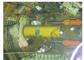
流域下水道への接続管工事 （正雀処理区編入事業）
