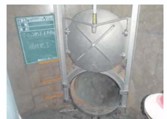
流域下水道への流量調整ゲート （正雀処理区編入事業）
