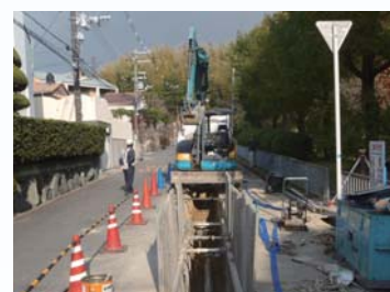
老朽管の布設替え工事
