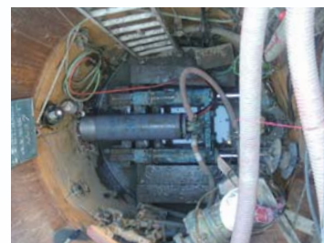
推進工事（万博公園南側）
