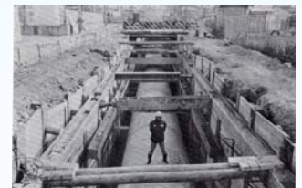
建設中の幹線管渠 （昭和49年頃の小路幹線）
