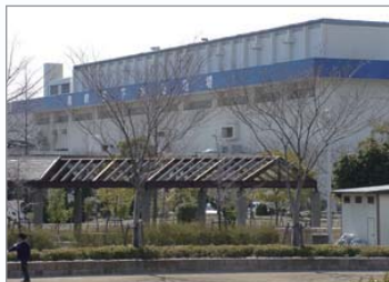
南吹田下水処理場
