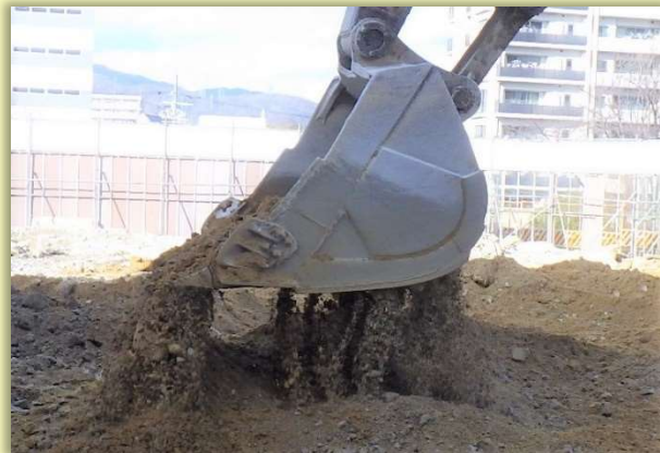
スケルトンバケットを使用するふるい分けの作業（例）
