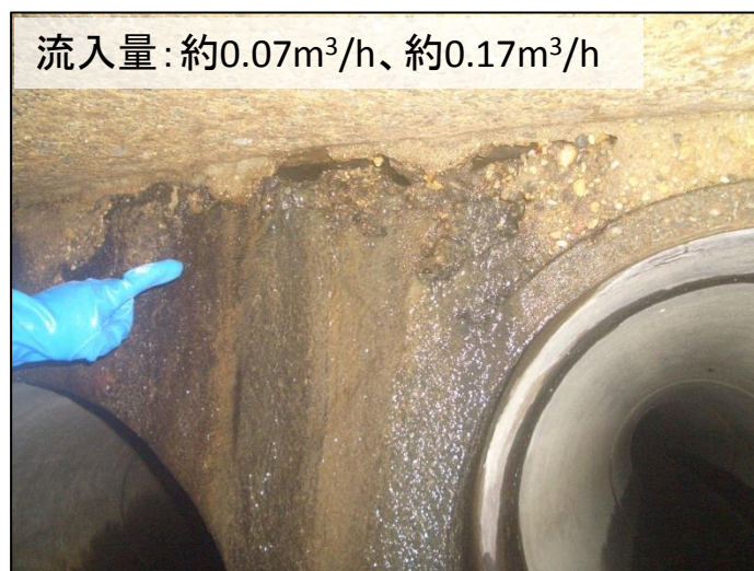
No.11マンホール 南側①②
