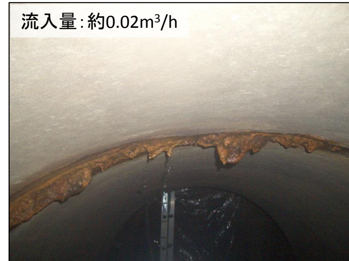
No.35マンホールより上流4m地点
