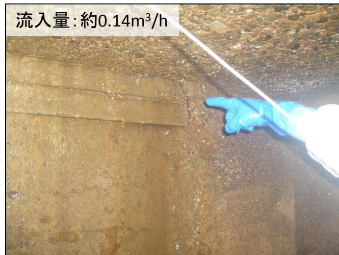
No.11マンホール 北側
