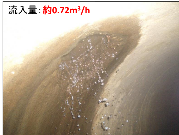
No.11マンホールより下流11.5m地点
