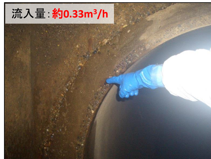
No.11マンホール 北東側
