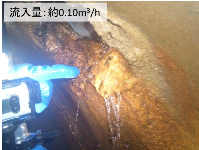
No.35マンホールより上流25m地点
