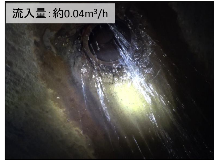
No.11マンホールより下流27.5m地点
