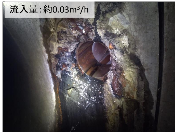
No.11マンホールより下流44.5m地点
