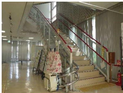
現公民館の屋内階段状況
